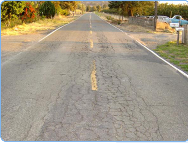
2005 yılında Bozulmaya yüz tutmuş bir yolun Chip Seal (Sathi kaplama) Yapılmadan önceki durumu.
