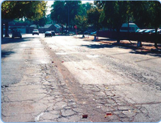
In anul 1999 un drum inainte de aplicare a Cape Seal'ului.
