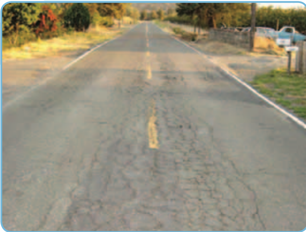
Состояние одной из начинающих портится дорог в 2005-м году до нанесения «Чип Сила» (поверхностной обработки).
