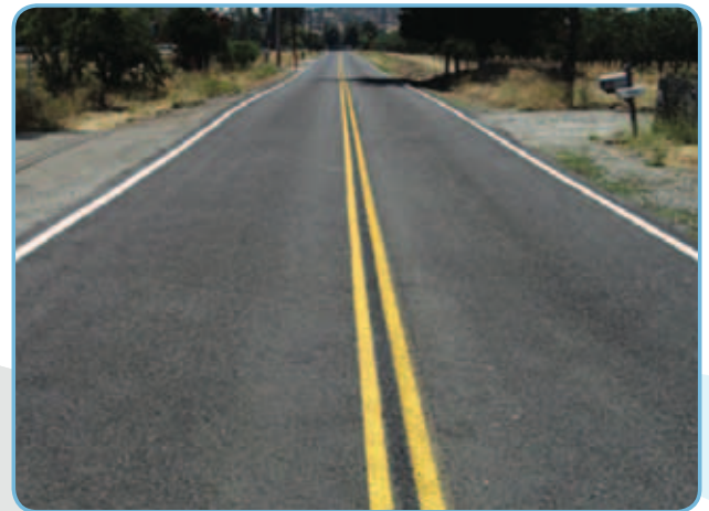
Состояние той же дороги через 3 года после ремонта в 2008-м году.
