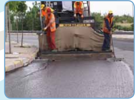
Son olarak standartlarına uygun olarak Slurry Seal uygulaması ile uygulama tamamlanır.
