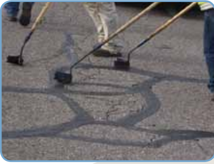
Öncelikle Uygulamanın yapılacağı yolda çatlaklar Tamir edilmelidir.
