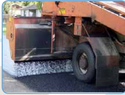
Standartlarına uygun olarak Chip Seal uygulaması yapılır
